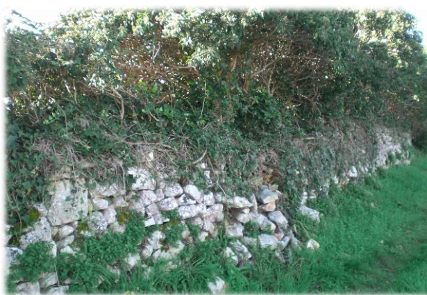
Figura 26 – Muretti a secco non mantenuti
